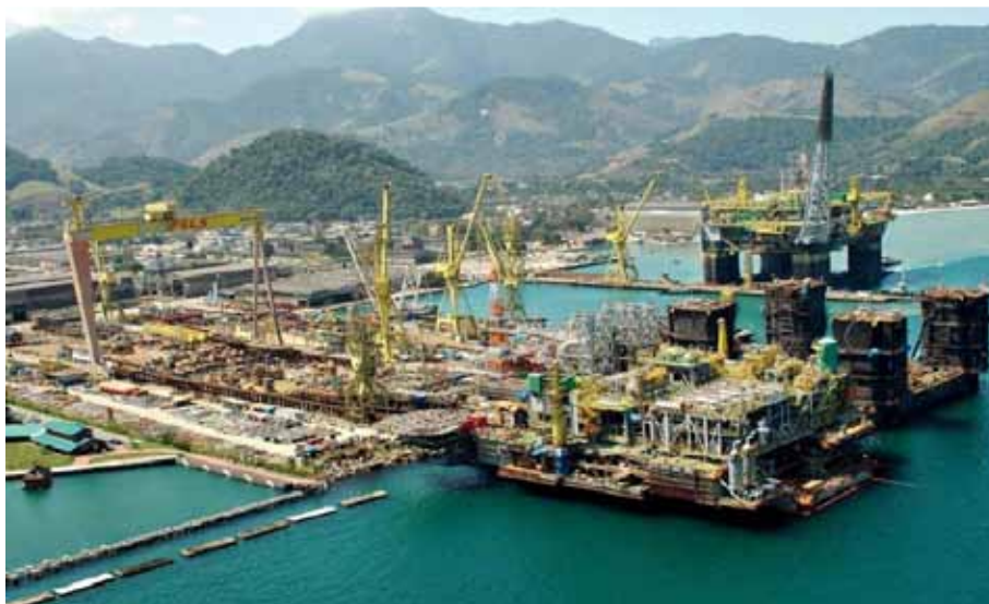
Figura 19: Estaleiro BrasFELS (Foto: Petrobras)
