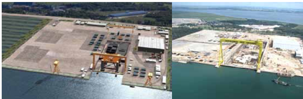
Figura 23: Layout do ERG1 e estágio da obras (março 2009) (Foto: Site da WTorre)
