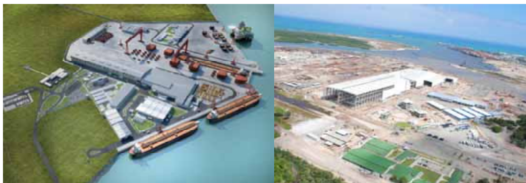
Figura 22: Layout do EAS e estágio das obras em dezembro 2008 (Foto: Site do Estaleiro)
