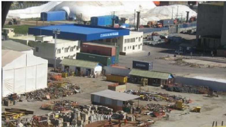
Figura 27: Canteiro de obras da QUIP em Rio Grande – RS
