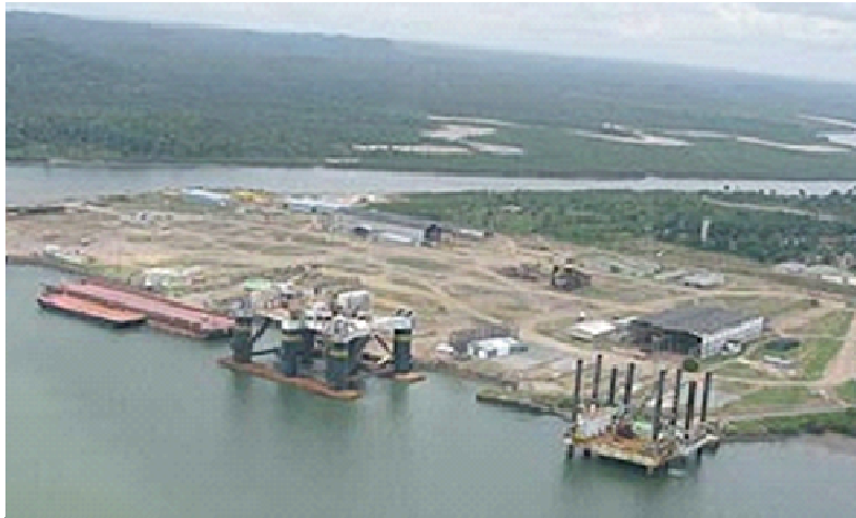
Figura 28: Estaleiro São Roque (Foto: Petrobras)
