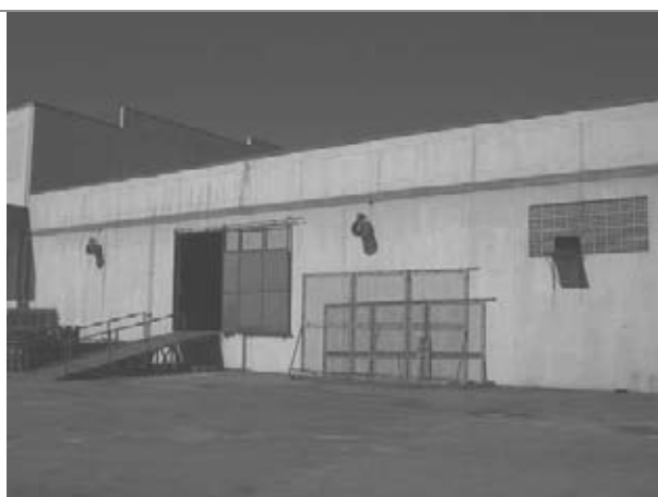
Bloco de apoio – galpão de empilhadeiras
