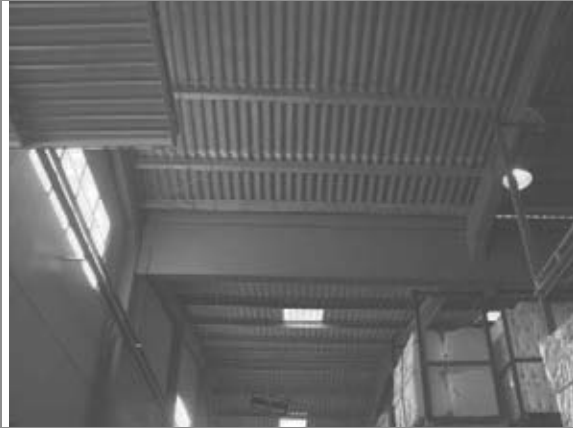
Galpão detalhe da cobertura, junto a entrada das docas
