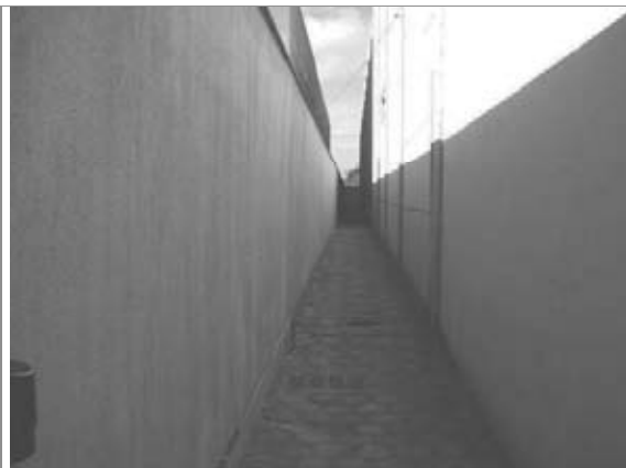
Recuo lateral, piso Blokret, muro de alvenaria
