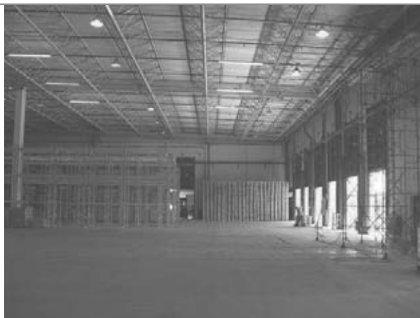
Detalhes internos do galpão
