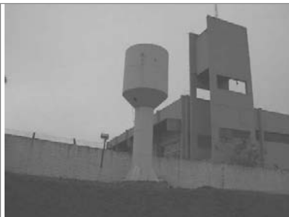
Vista da caixa d'água metálica
