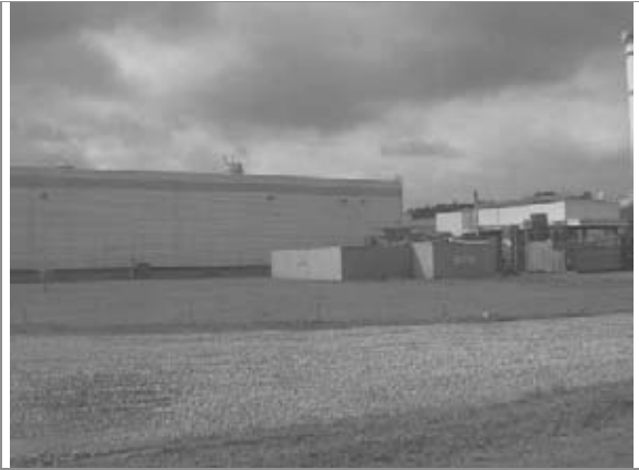
Vista geral do galpão
