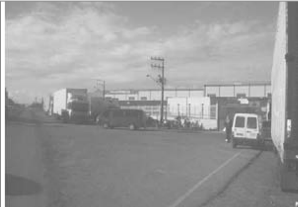
Vista geral da entrada do Galpão da Magazine Luiza
