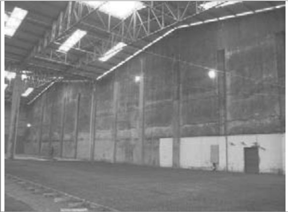
Vista parcial interna do Novo Galpão CD
