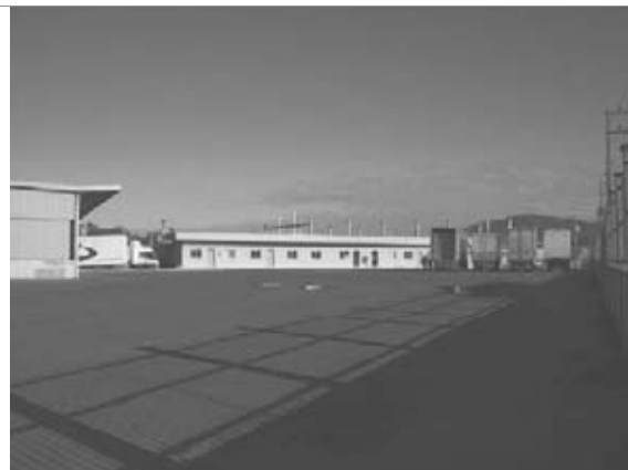
Pátio de estacionamento, piso asfáltico
