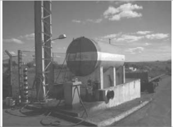
Reservatório de Inflamável
