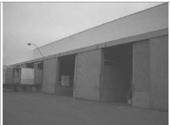
Vista parcial externa do Galpão CD
