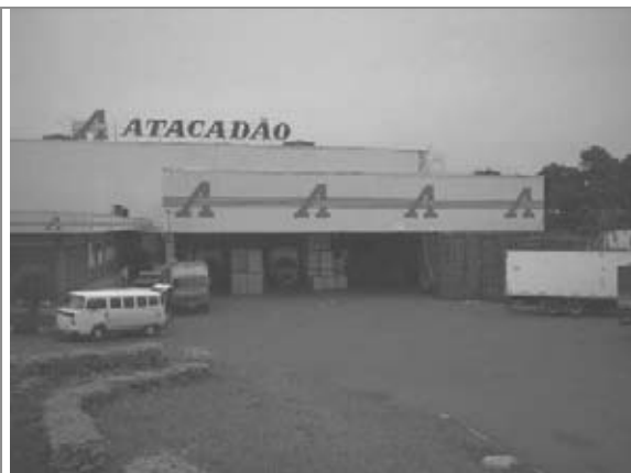
Vista parcial externa do Galpão CD
