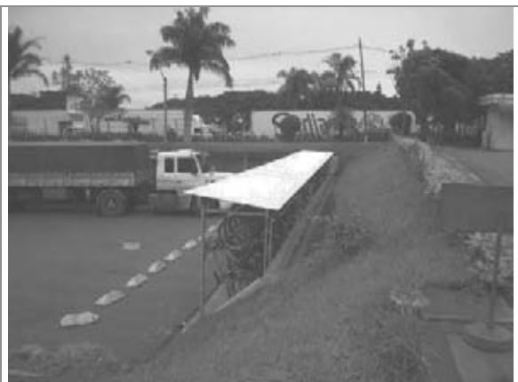
Vista parcial do bicicletário
