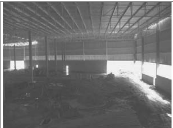
Vista parcial do interior do galpão
