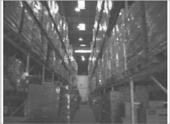
Vista parcial interna do Galpão CD
