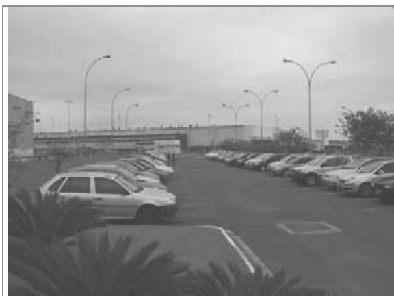
Estacionamento – pavimentação asfáltica
