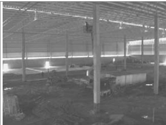
Vista parcial do interior do galpão
