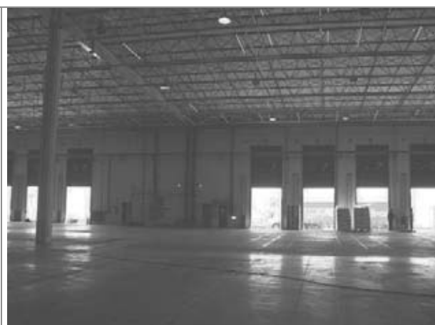
Detalhes internos do galpão
