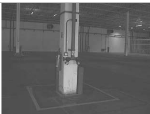
Detalhes internos do galpão
