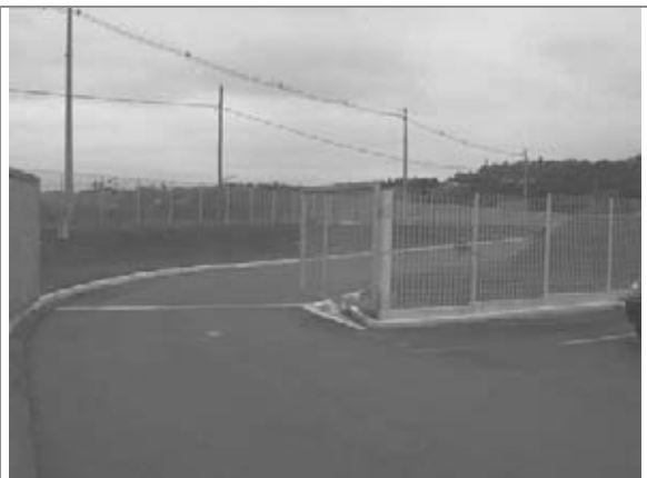
Pavimentação e fechamento lateral
