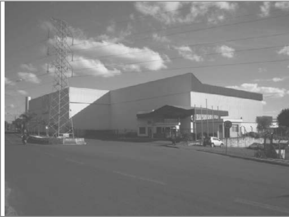
Vista geral da fachada do imóvel
