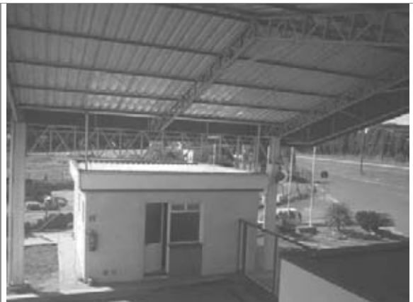
Detalhe da cobertura
