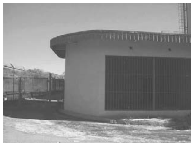
Apoio – casa de máquinas
