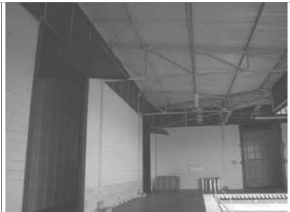
Detalhe da plataforma
