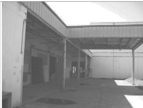
Bloco de apoio – galpão de empilhadeiras
