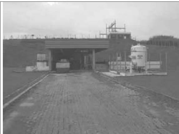
E.T.A. / E.T.E / Depósito de GLP
