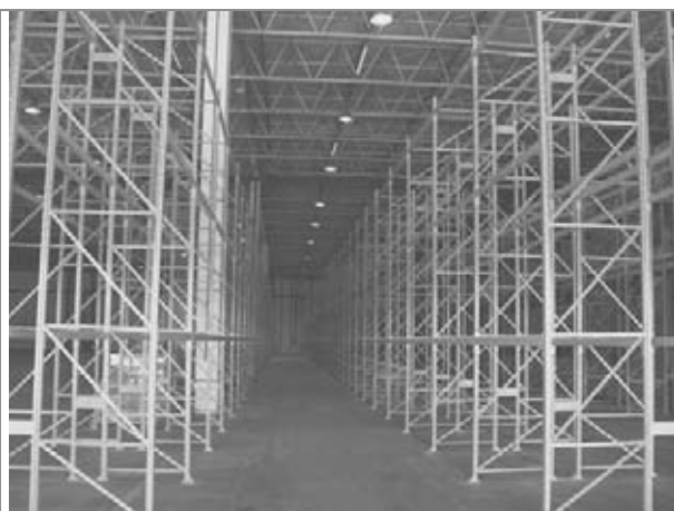
Detalhes internos do galpão
