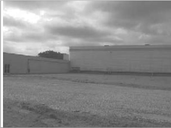
Vista geral do galpão
