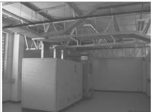
Pavimento superior – cabine primária
