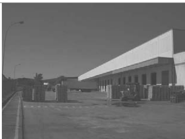
Pátio e galpão
