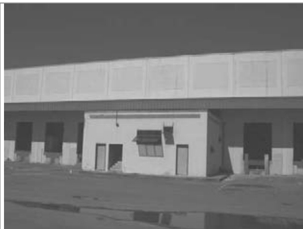
Vista do Galpão
