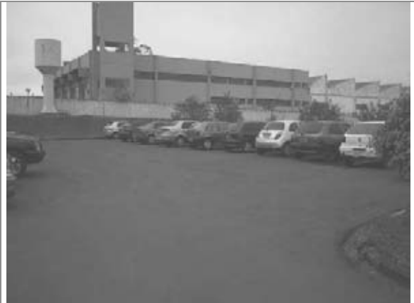
Vista parcial da pavimentação externa
