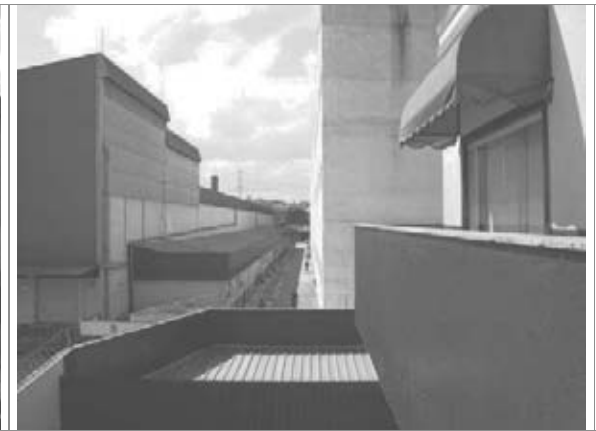
Vista parcial externa do galpão
