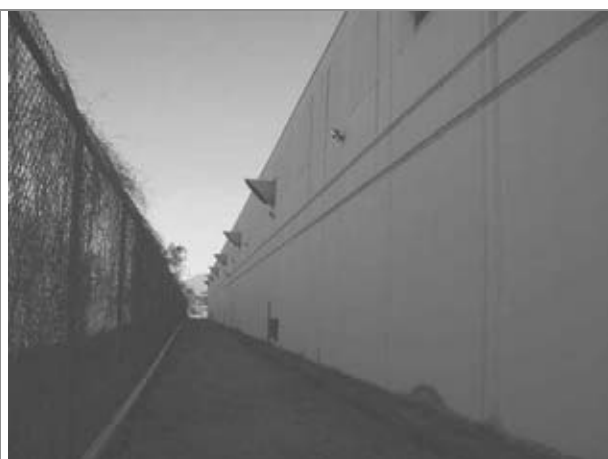
Galpão – fachada lateral
