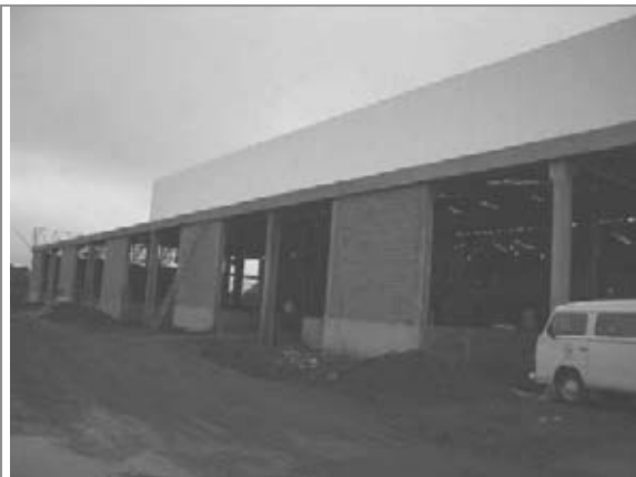
Vista parcial externa do Novo Galpão CD
