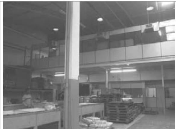
Interna do Galpão 1
