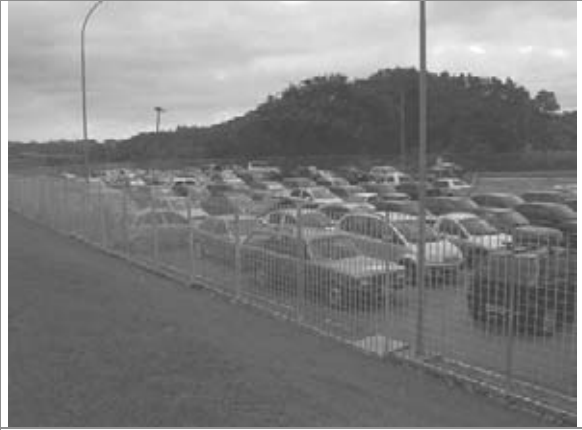
Fechamento lateral e pavimentação asfáltica
