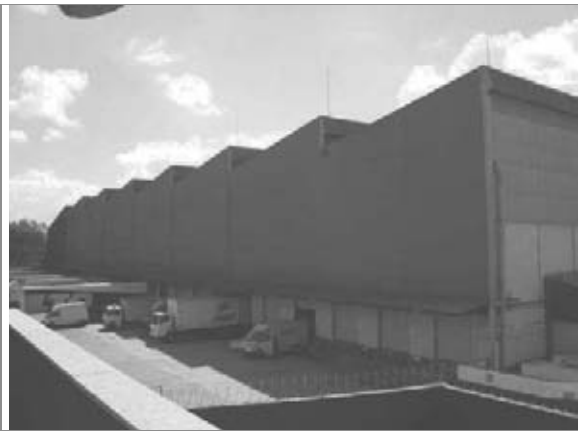
Vista parcial externa do galpão
