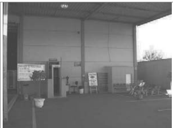
Acesso ao Galpão
