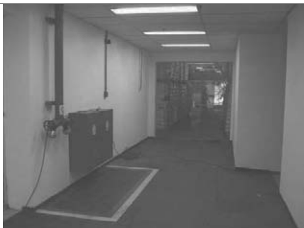
Acesso a área de armazenagem
