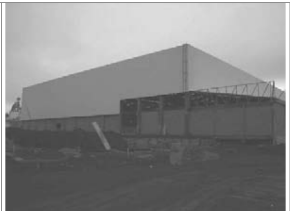
Vista parcial externa do Novo Galpão CD
