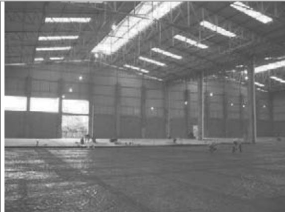
Vista parcial interna do Novo Galpão CD
