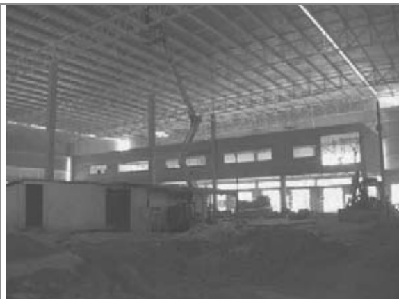
Vista da área administrativa
