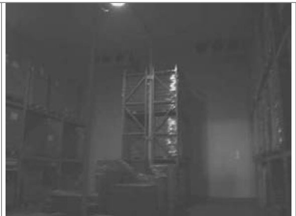
Vista parcial interna do Galpão CD (câmara frig)
