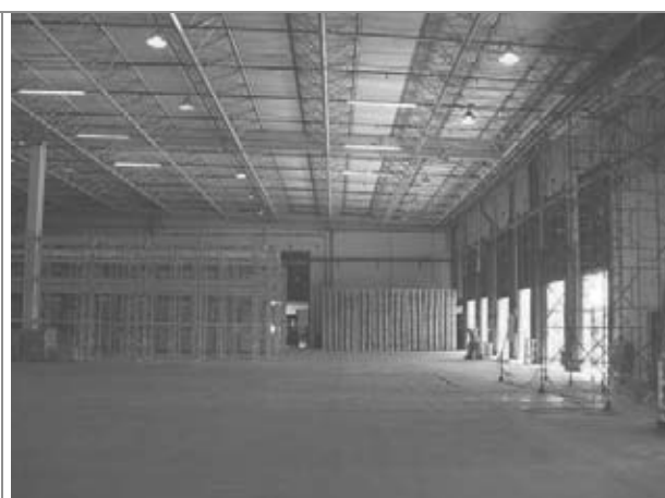
Detalhes internos do galpão
