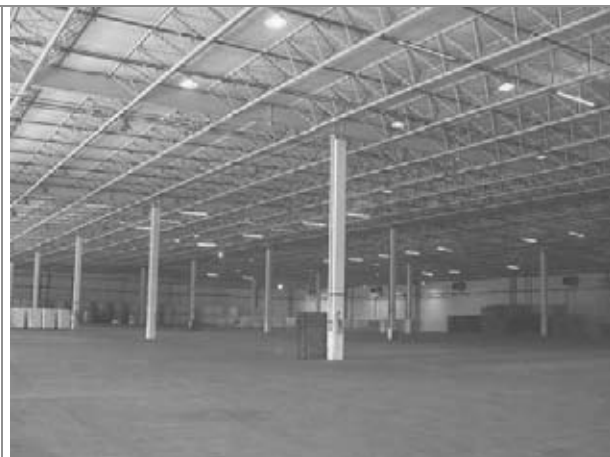
Detalhes internos do galpão
