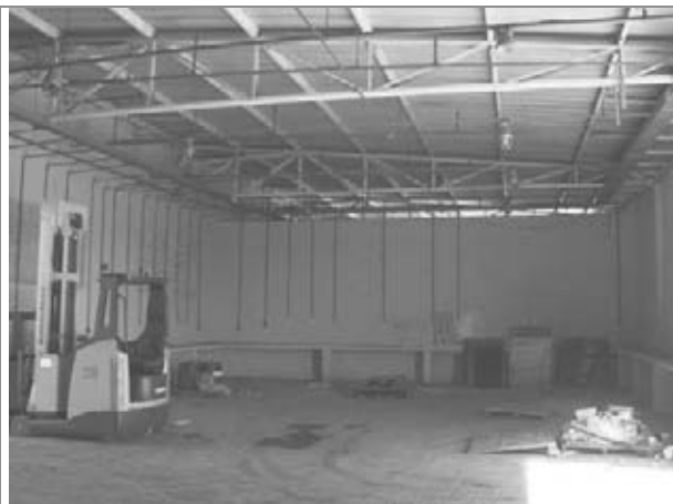
Bloco de apoio – galpão de empilhadeiras
