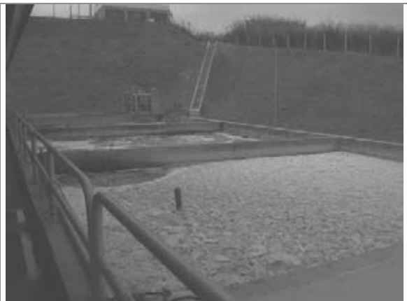
Tanque de reuso
