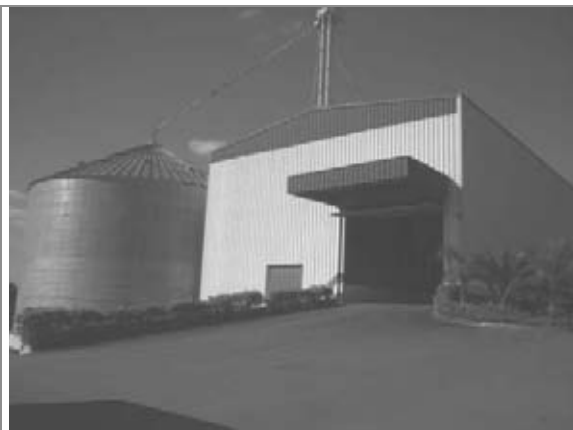
Galpão da Moega
