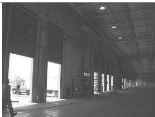
Detalhes internos do galpão
