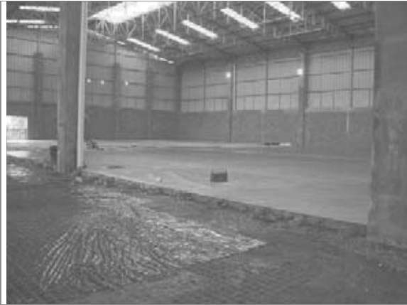
Vista parcial interna do Novo Galpão CD
