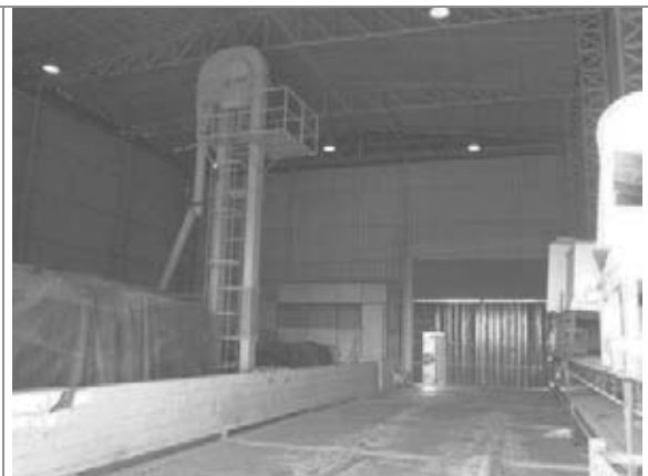
Galpão da Moega
